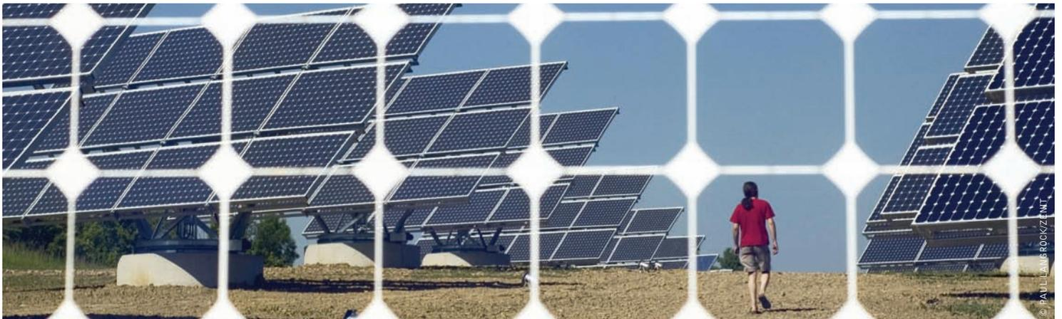
imagen INSTALACIÓN SOLON AG PHOTOVOLTAICS EN ARNSTEIN, OPERA 1500 "MOVERS" SOLARES HORIZONTALES Y VERTICALES. ES LA INSTALACIÓN DE RASTREO SOLAR MÁS GRANDE DEL MUNDO.
