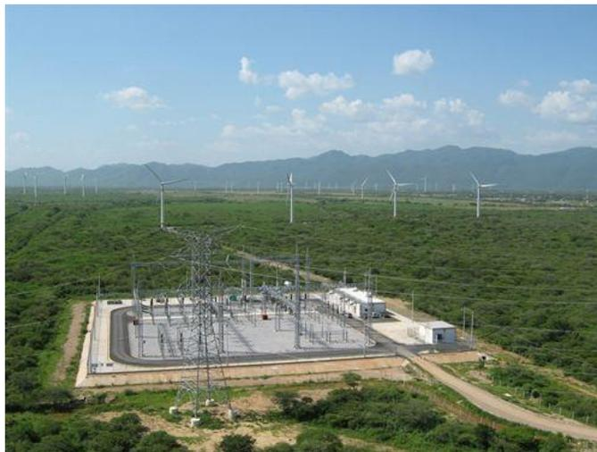
Para ello, la Compañía ha instalado 11 nuevos aerogeneradores de última generación del modelo G80 de Gamesa, de 2 MW de potencia unitaria y una altura de 78 metros.
