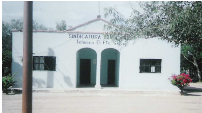
Figura 4. Sindicatura de Tehueco.
