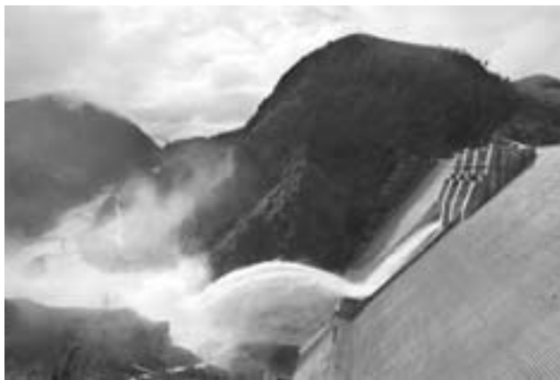
Central Hidroeléctrica Ralko de Endesa-España, Alto Bio Bio. © Pablo Díaz
