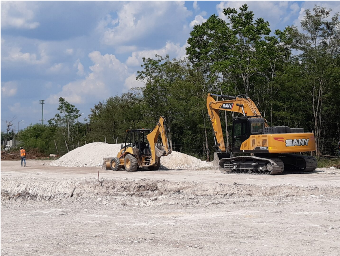
Obra en el tramo 1 de la ruta del Tren Maya. (Imagen: Emilio Godoy)
