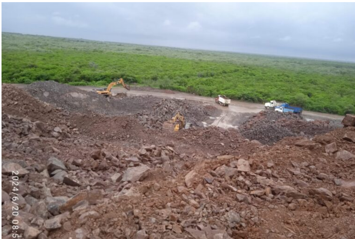
Obras y remoción de material en el Cerro Guie para rehabilitar la Línea K del Tren Interoceánico. Foto: cortesía Édgar Martín
