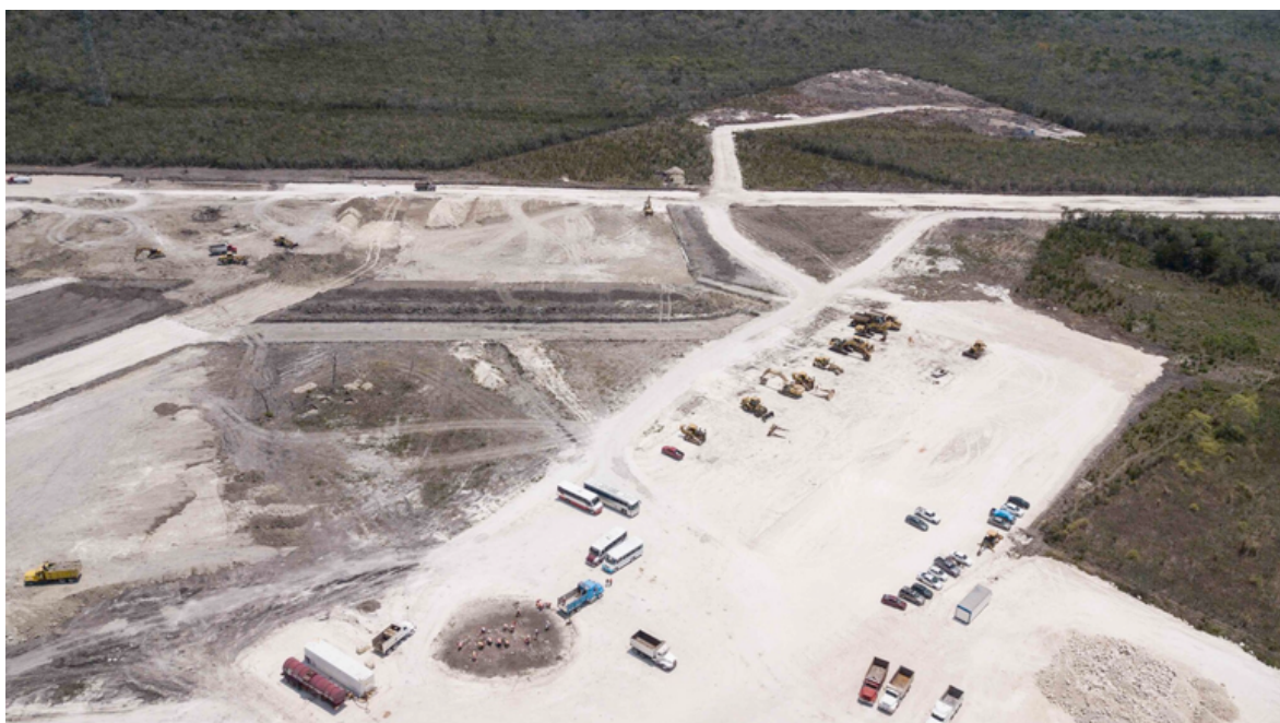
Militares realizan la construcción de la estación del tren en el tramo 7, en Xpujil, Campeche. Foto: Isabel Mateos.
