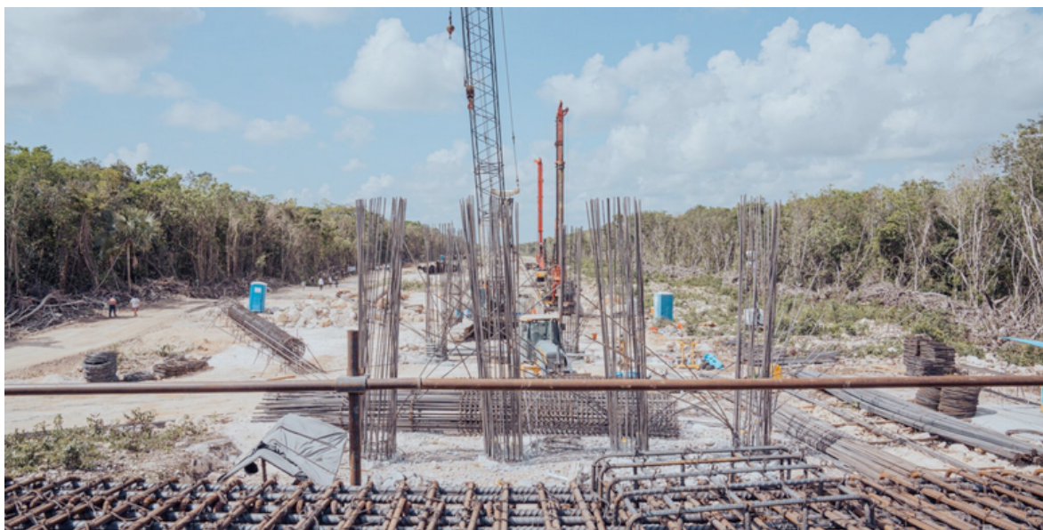
Una de las zonas de la Selva Maya en donde se construye el Tramo 5 del llamado Tren Maya. Foto: @CCMSSAC.
