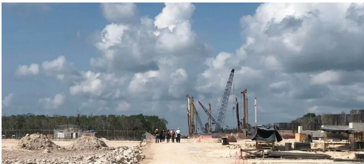
Una de las zonas en donde se construye el Tramo 5 del llamado Tren Maya. Foto: Neify Pat/Múuch' Xiinbal.
