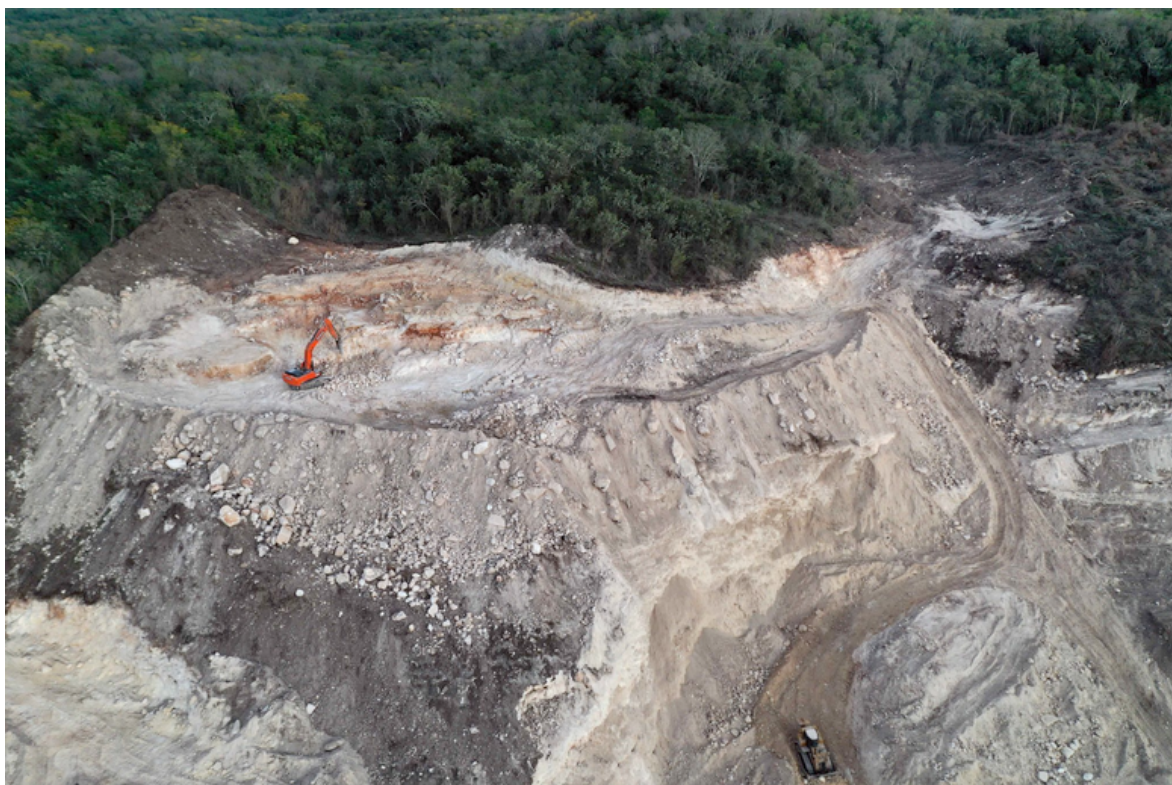
Obras realizadas alrededor del Tren Maya, en el estado de Campeche. Foto: Robin Canul.
