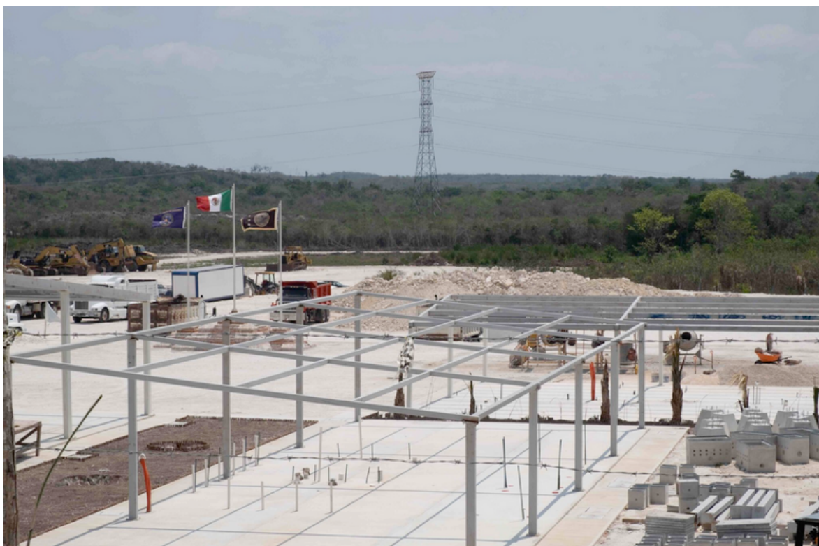
Construcción de una de las estaciones del Tren Maya, en el municipio de Xpujil, Campeche. Foto: Isabel Mateos.
