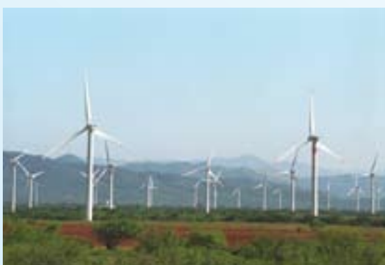
Figura 1. Central eoloelectrica La Venta II.
