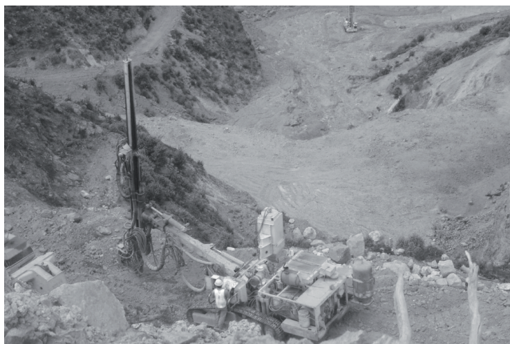
Mineros cargando un barreno de explosivos
