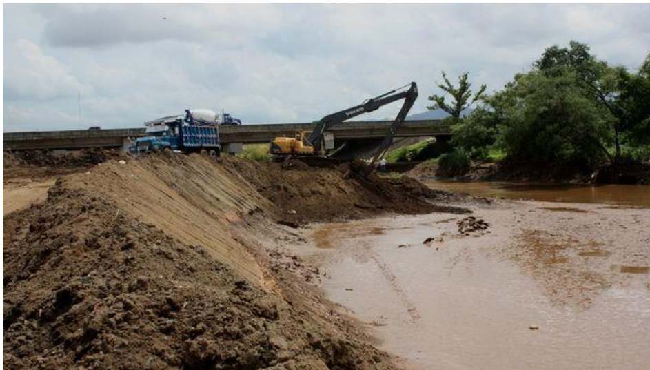
Imagen referencial. Trabajos de dragado en río Juan Díaz, en Panamá. Fuente de la imagen: Telemetro.com
